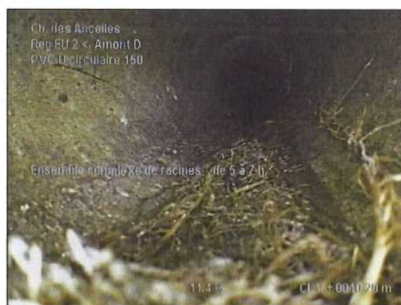
Photo: 5_5_38_A.JPG 10,2m, Ensemble complexe de racines , de 5 à 7 h.
