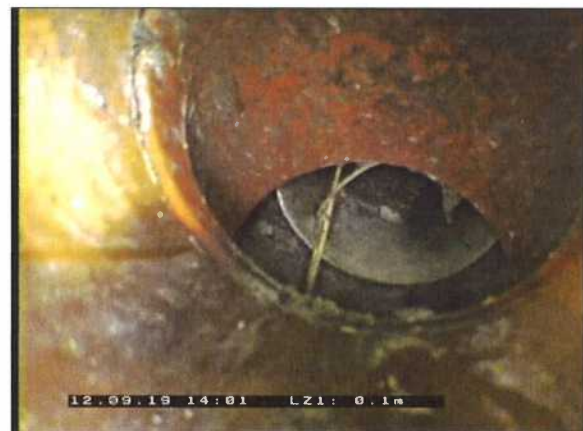
Photo: 7_7_57_A.jpg 0,1m, Inspection abandonnée / caméra ne passe pas
