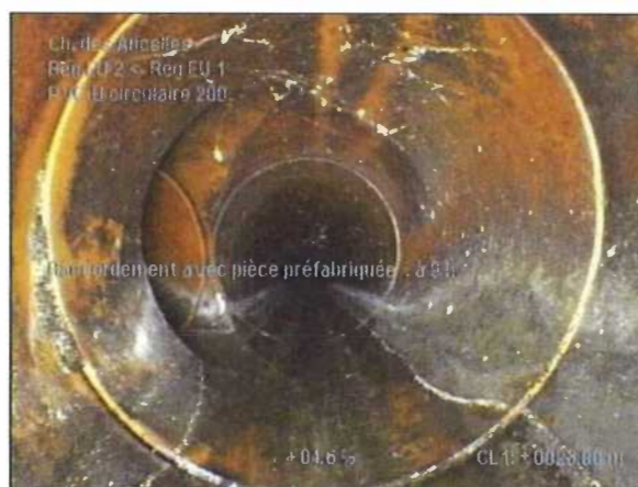
Photo: 1_1_12_A.JPG 23,8m, Raccordement avec pièce préfabriquée , à 9 h.
