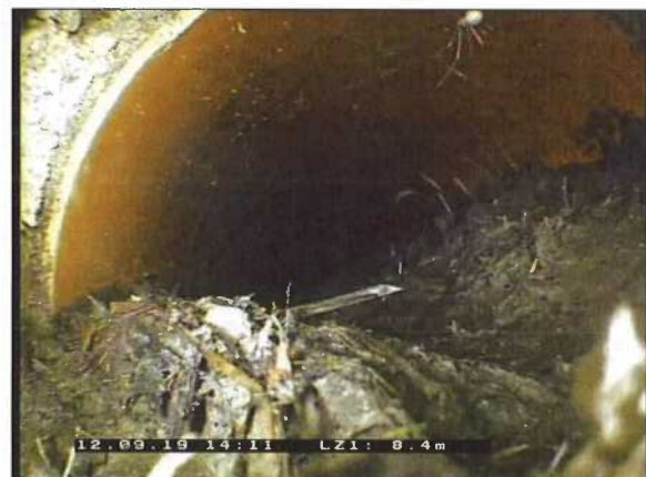
Photo: 8_8_68_A.jpg 8,41m, Inspection abandonnée / cause dépôts
