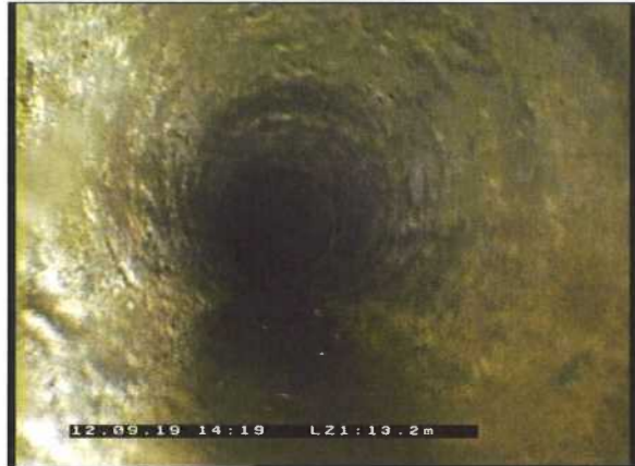
Photo: 9_9_75_A.jpg 13,2m, Granulats exposés , de 12 à 12 h.
