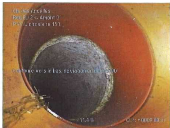
Photo: 5_5_35_A.JPG 9,8m, Courbure vers le bas, déviation en degrés 90°
