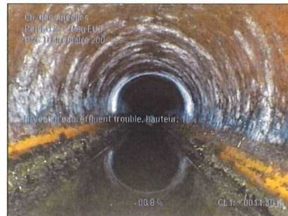
Photo: 4_4_22_A.JPG 14,3m, Niveau d'eau, effluent trouble, hauteur: 10%
