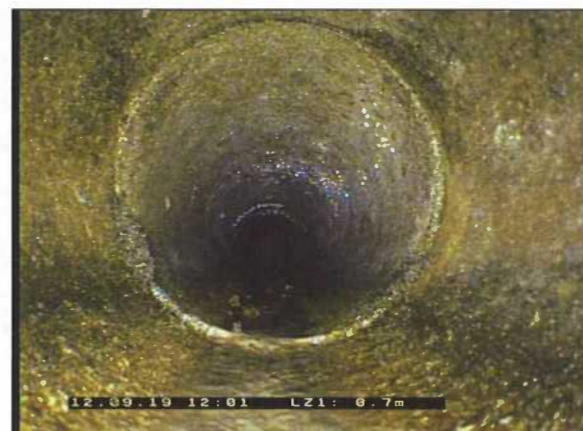
Photo: 6_6_48_A.jpg 0,7m, Éclat / partie de paroi manquants%AJoint% , de 3 à 9 h.
