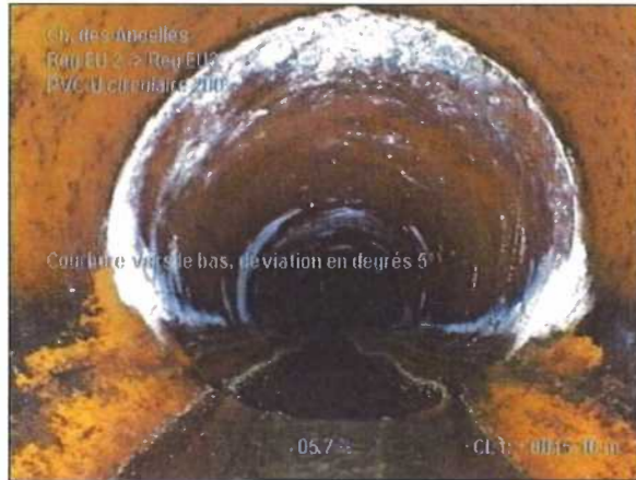
Photo: 4_4_26_A.JPG 45,1m, Courbure vers le bas, déviation en degrés 5°
