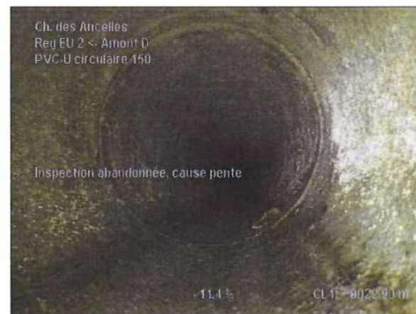
Photo: 5_5_42_A.JPG 22,9m, Inspection abandonnée / cause pente
