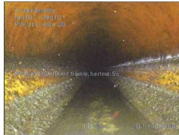
Photo: 1_1_4_A.JPG 13,5m, Niveau d'eau, effluent trouble, hauteur: 5%
