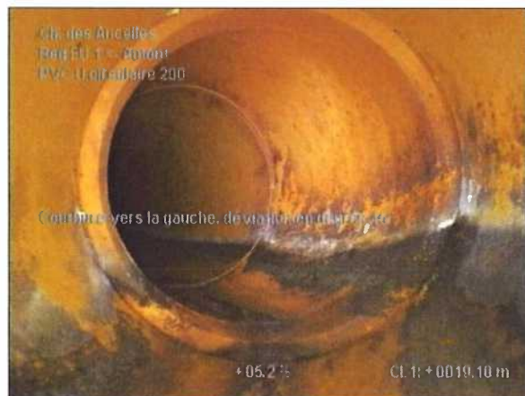
Photo: 3_3_17_A.JPG 19,1m, Courbure vers la gauche, déviation en degrés 45°
