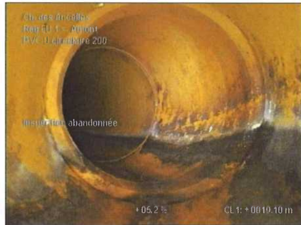
Photo: 3_3_19_A.JPG 19,1m, Inspection abandonnée
