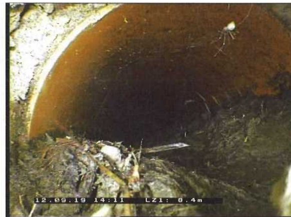
Photo: 8_8_65_A.jpg 8,4m, Dépôts , hauteur: 50%, de 3 à 9 h.
