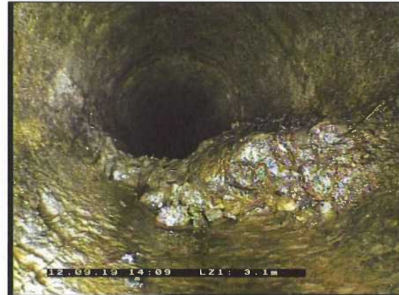
Photo: 8_8_63_A.jpg 3,1m, Concrétions , de 4 à 8 h.
