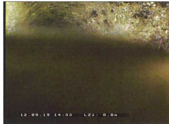
Photo: 10_10_83_A.jpg 0,8m, Niveau d'eau, effluent trouble, hauteur: 50%
