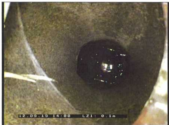
Photo: 7_7_56_B.jpg 0,1m, Courbure vers le bas, déviation en degrés 90°
