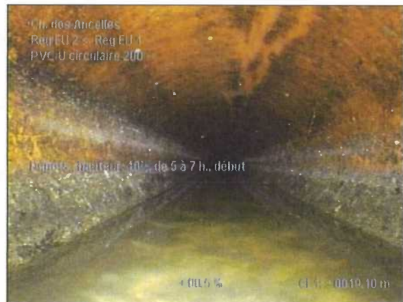
Photo: 1_1_8_A.JPG 19,1m, Dépôts , hauteur: 10%, de 5 à 7 h., début
