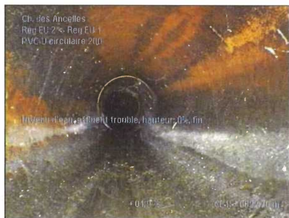
Photo: 1_1_11_A.JPG 22,7m, Niveau d'eau, effluent trouble, hauteur: 0% / fin
