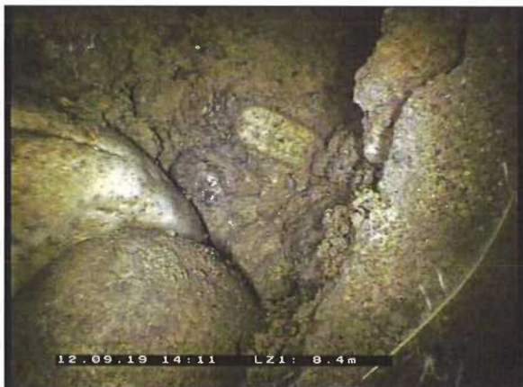
Photo: 8_8_67_B.jpg 8,4m, Éclat / partie de paroi manquants , de 9 à 3 h.
