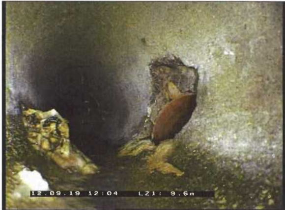
Photo: 6_6_51_A.jpg 9,8m, Raccordement carotté , à 3 h.
