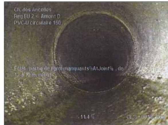
Photo: 5_5_40_A.JPG 13,2m, Éclat / partie de paroi manquants%AtJoint% , de 12 à 12 h., début
