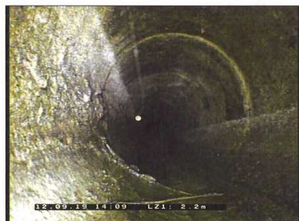
Photo: 8_8_61_A.jpg 2,2m, Éclat / partie de paroi manquants%AtJoint% , de 12 à 12 h., début
