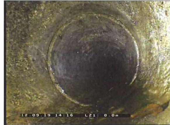
Photo: 9_9_72_A.jpg 0,1m, Éclat / partie de paroi manquants%AtJoint% , de 12 à 12 h., début
