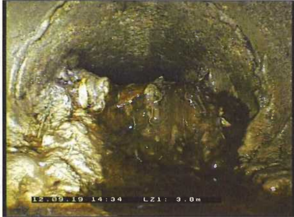
Photo: 10_10_84_A.jpg 3,8m, Concrétions , réduction de section transversale 50%, de 3 à 9 h.
