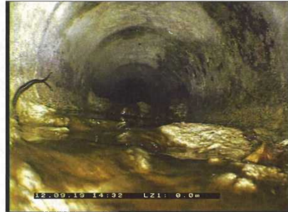
Photo: 10_10_81_A.jpg 0,01m, Concrétions , réduction de section transversale 30%, de 5 à 7 h.
