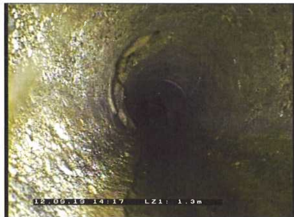
Photo: 9_9_73_A.jpg 1,3m, Granulats exposés , de 12 à 12 h., début
