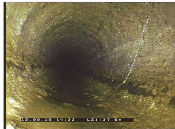
Photo: 9_9_78_A.jpg 37,6m, Inspection abandonnée / cause distance
