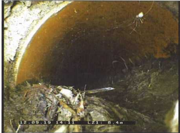
Photo: 8_8_66_A.jpg 8,4m, Changement du matériau de la canalisation: chlorure de polyvinyle
