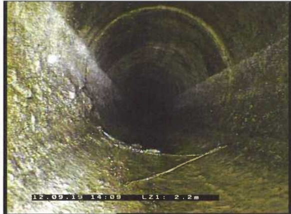
Photo: 8_8_62_A.jpg 2,2m, Granulats exposés , de 3 à 9 h., début
