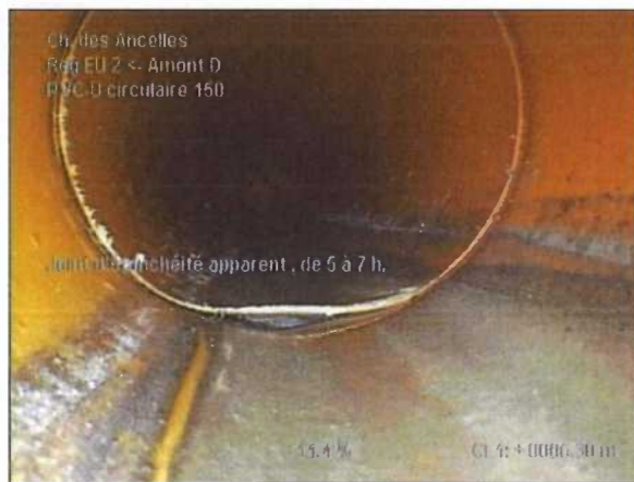
Photo: 5_5_33_A.JPG 6,3m, Joint d'étanchéité apparent, de 5 à 7 h.
