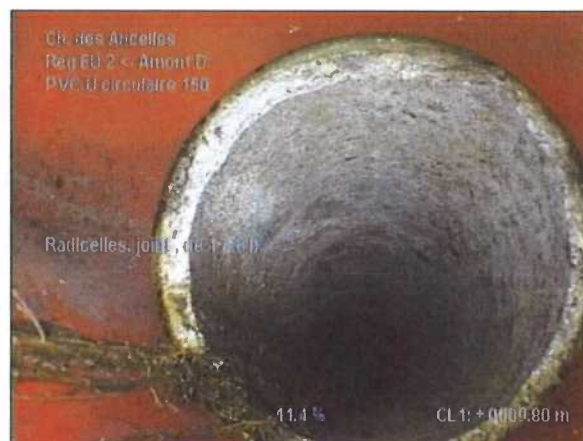
Photo: 5_5_36_A.JPG 9,8m, Radicelles, joint , de 4 à 8 h.
