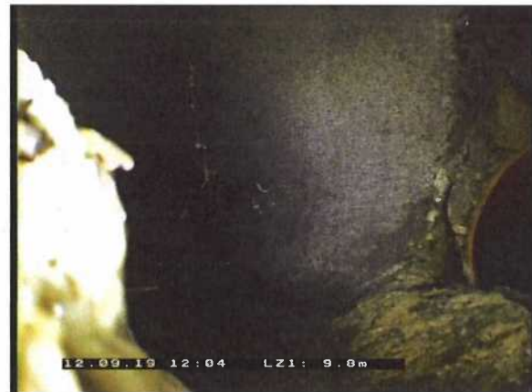
Photo: 6_6_55_A.jpg 9,82m, Inspection abandonnée
