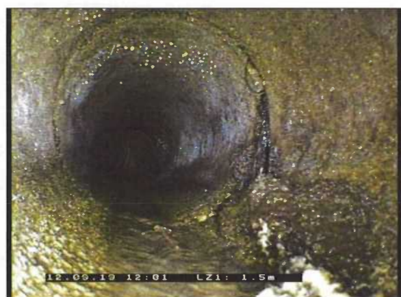
Photo: 6_6_49_A.jpg 1,5m, Ensemble complexe de racines , de 3 à 5 h.
