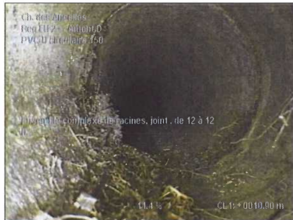
Photo: 5_5_39_A.JPG 10,9m, Ensemble complexe de racines, joint , de 12 à 12 h.
