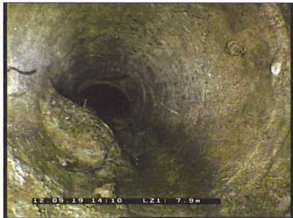
Photo: 8_8_64_A.jpg 7,9m, Dépôts , hauteur: 30%, de 6 à 8 h.
