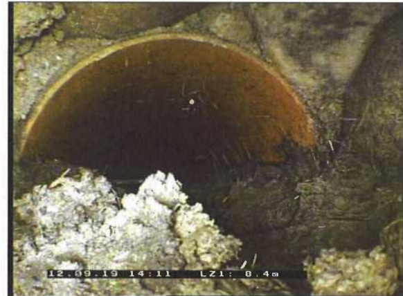
Photo: 8_8_67_A.jpg 8,4m, Éclat / partie de paroi manquants , de 9 à 3 h.
