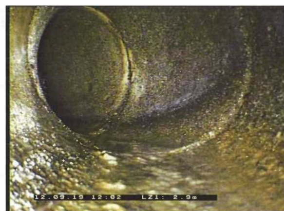
Photo: 6_6_50_A.jpg 2,9m, Courbure vers la gauche, déviation en degrés 90° / 2x45°
