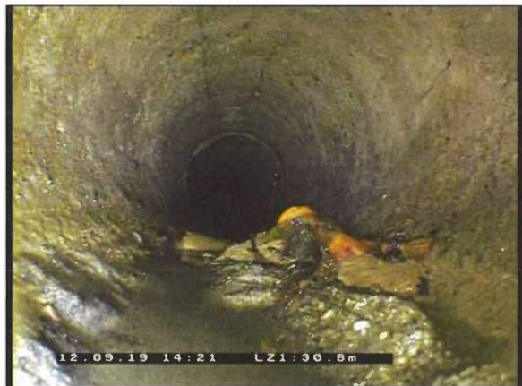
Photo: 9_9_77_A.jpg 30,8m, Dépôts , hauteur: 10%, de 5 à 7 h.
