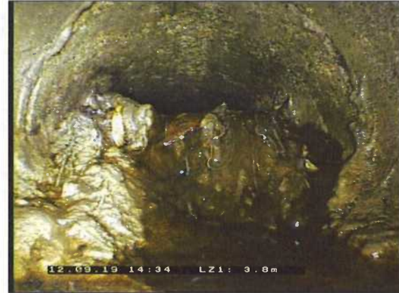
Photo: 10_10_85_A.jpg 3,8m, Inspection abandonnée / cause dépôt
