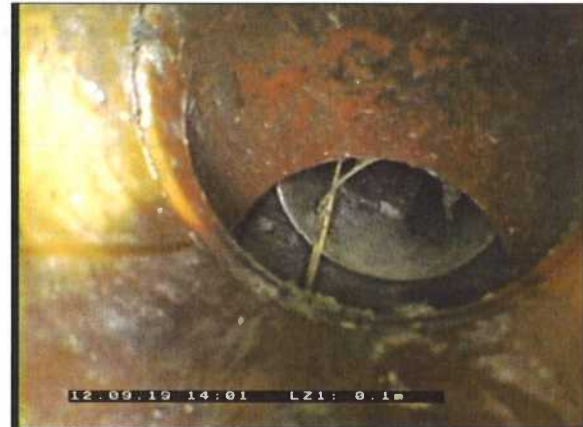
Photo: 7_7_56_A.jpg 0,1m, Courbure vers le bas, déviation en degrés 90°
