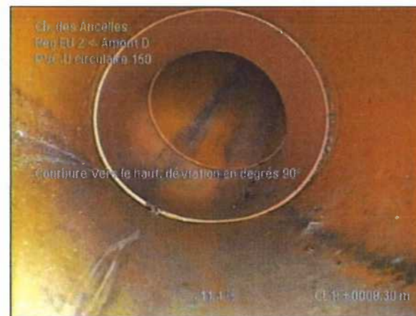
Photo: 5_5_34_A.JPG 8,3m, Courbure vers le haut, déviation en degrés 90°
