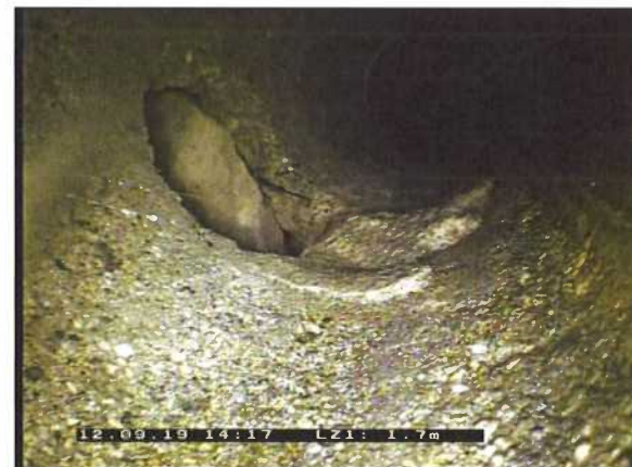
Photo: 9_9_74_A.jpg 1,7m, Raccordement carotté , à 9 h.
