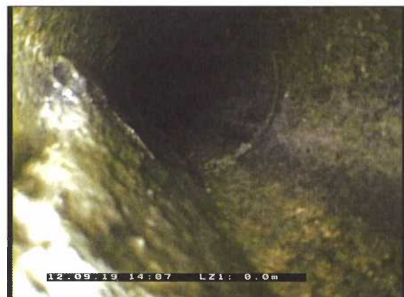
Photo: 8_8_59_A.jpg 0m, Dépôts durs , hauteur: calcaire % , de 5 à 7 h., début
