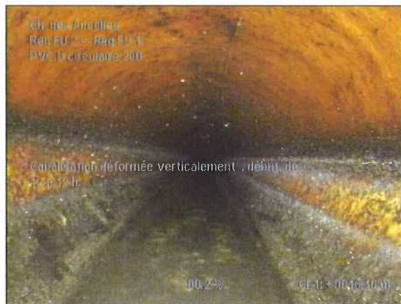
Photo: 1_1_5_A.JPG 16,1m, Canalisation déformée verticalement, début, de 12 à 12 h.
