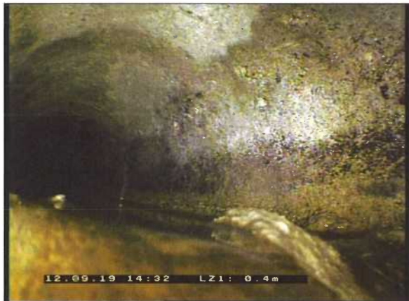
Photo: 10_10_82_A.jpg 0,4m, Concrétions , réduction de section transversale 40%, de 4 à 8 h.
