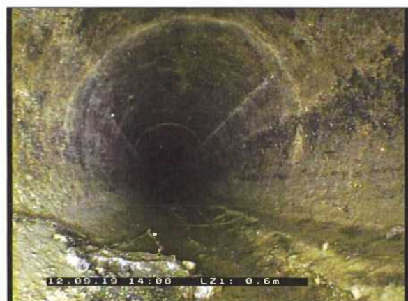
Photo: 8_8_60_A.jpg 0,6m, Fissure superficielle (micro-fissure) radiale , de 9 à 3 h.
