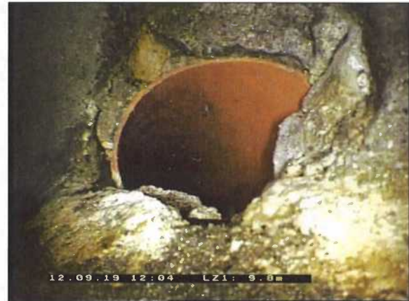
Photo: 6_6_51_B.jpg 9,8m, Raccordement carotté , à 3 h.
