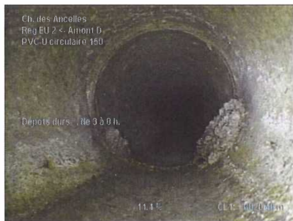
Photo: 5_5_41_A.JPG 20,4m, Dépôts durs , de 3 à 8 h.
