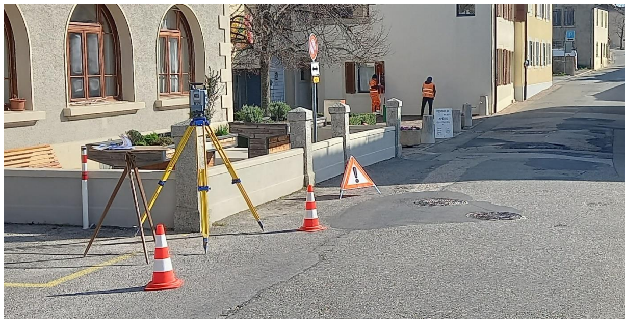
Travaux de relevés dans le cadre du mandat d'ingénieur.
